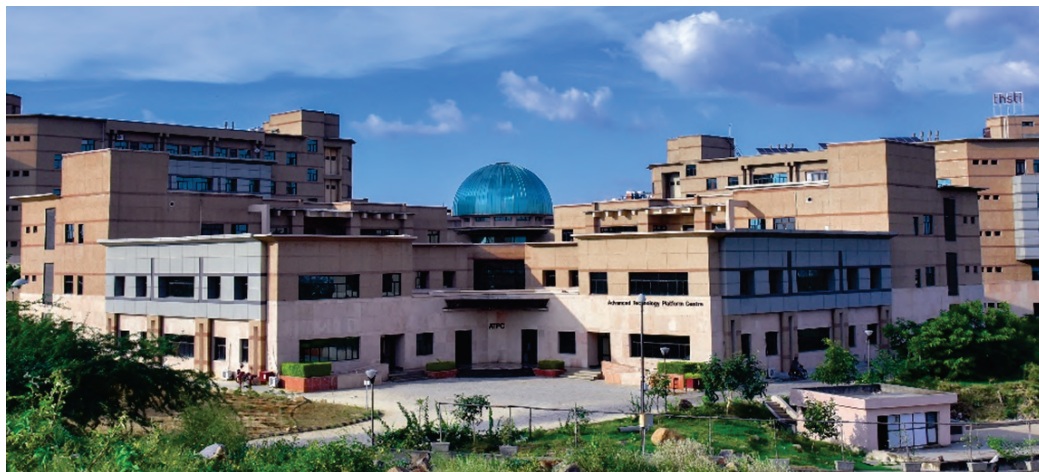
चित्र 1: एटीपीसी-बीबीबी भवन की तस्वीर प्रदर्शित की गई है। इस भवन की निचली मंजिल पर एटीपीसी सुविधाएं उपलब्ध हैं।
